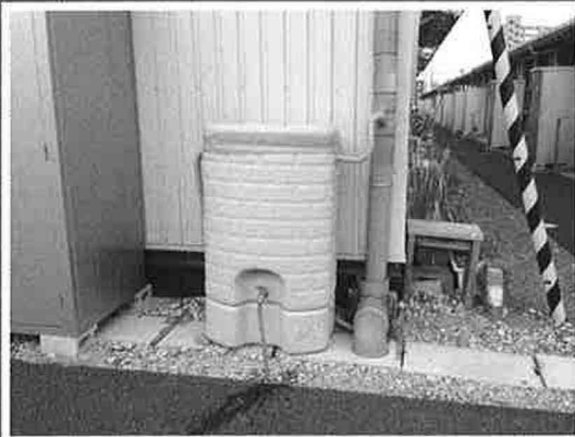
仮設住宅の雨水タンク（仙台市内）
