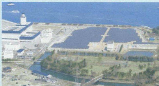
東北電力(株)仙台太陽光発電所 (七ヶ浜町)
